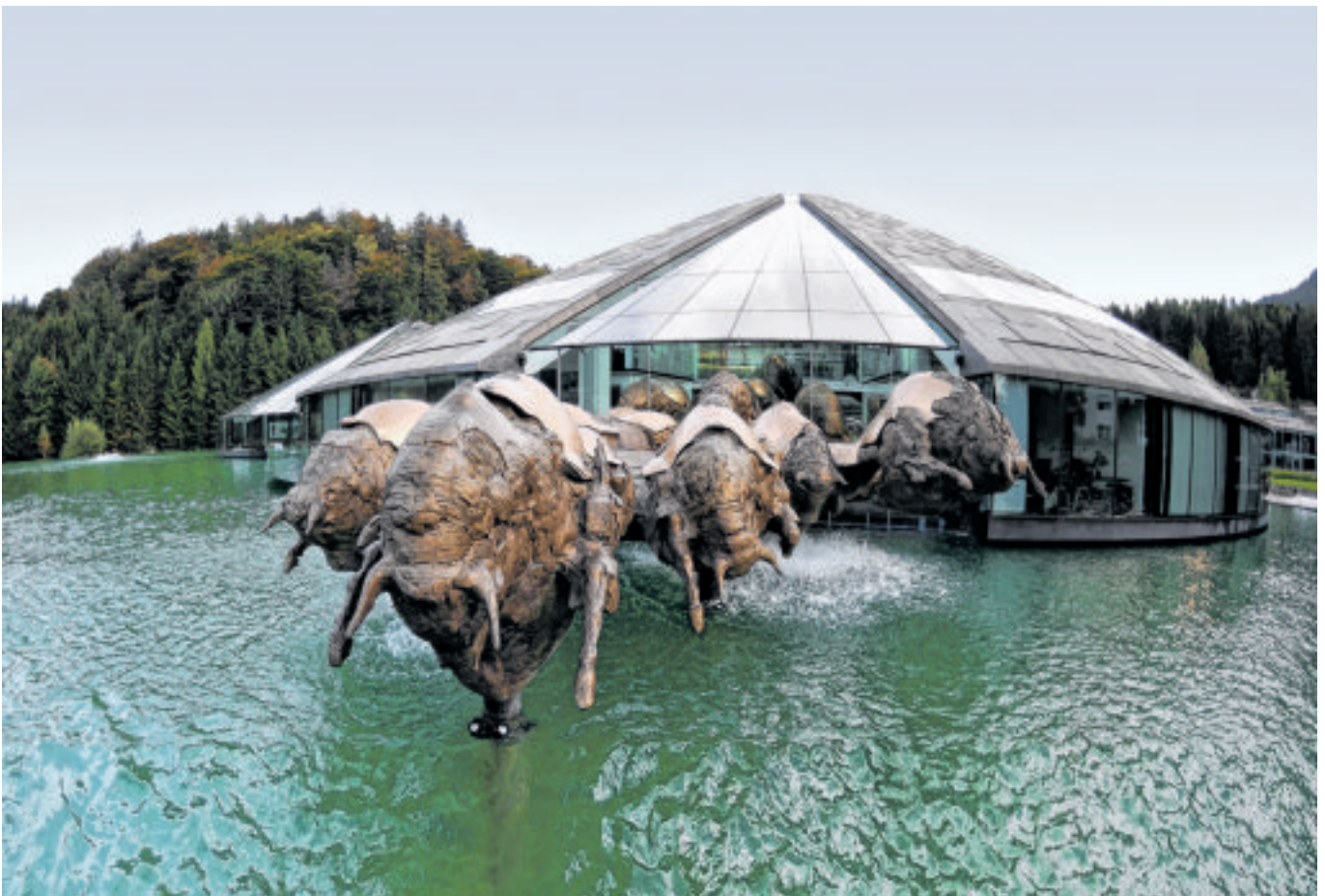
Die „Bullen von Fuschl“ gelten als Wahrzeichen des Headquarters von Red Bull, das in Fuschl am See liegt.
